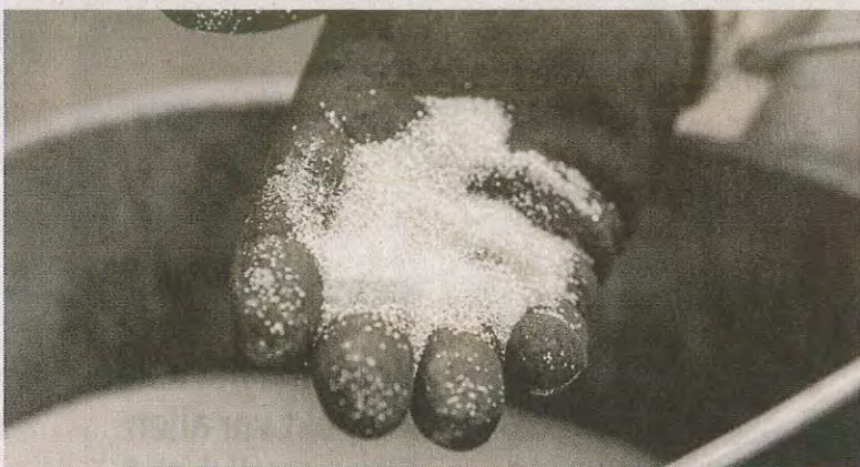
Zuletzt werden winzige Glasperlen auf den Thermoplastik-Belag aufgestreut. Sie sorgen bei Dunkelheit für Lichtreflexionen. Die Bauarbeiter nennen die Perlen „Sternstaub“.
