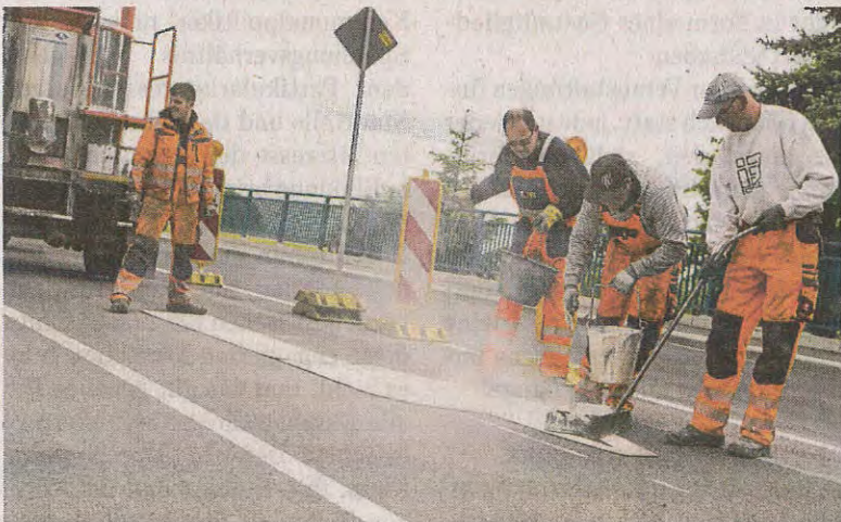
Bauarbeiter bringen in Teamarbeit die Linksabbiegerspur von der Bundesstraße 1 nach Lamme auf die Fahrbahn.
