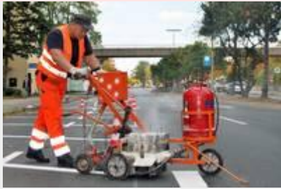
Jens Pfenning von der Firma FVG Fahrbahnmarkierung und Verkehrsleittechnik bringt die neuen Parkflächen-Markierungen auf.
